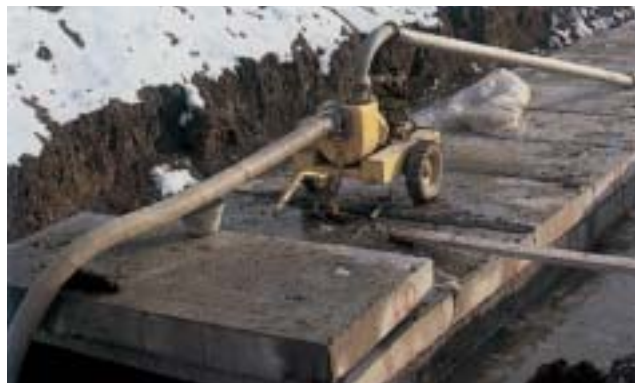
J156-5 pump used as a by-pass for waste water. Pompe J156-5 utilisée comme by-pass pour les eaux usées.
